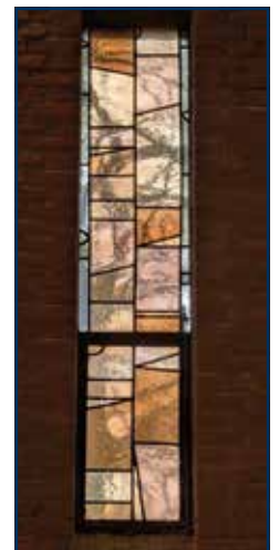
Fenster im Kirchenschiff zur Nordseite
