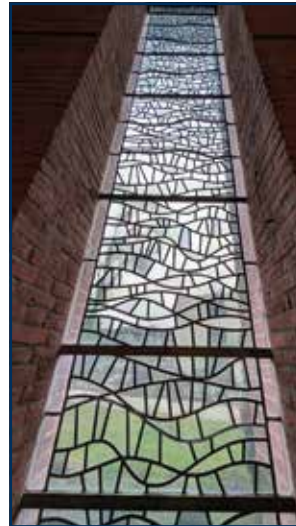
Fenster Richtung Süden
