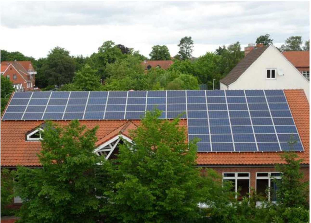
Abbildung: Fotovoltaikanlage Gemeindehaus
